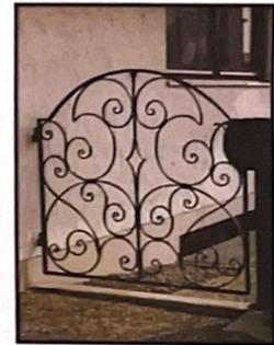
Alle Gewerke sind korrossionsgeschützt (feuerverzinkt) und mit einem Spezialanstrich versehen. Beide Maßnahmen zusammen machen sie auf viele Jahre hin absolut wartungsfrei.
